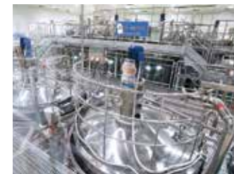
原料液タンク
